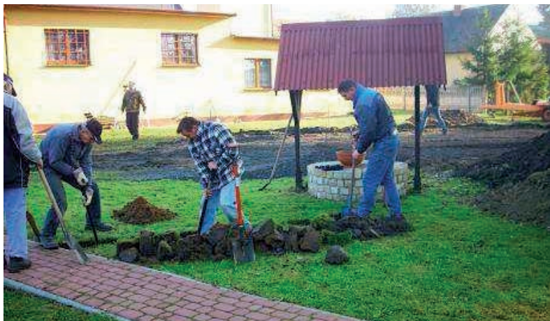
Prace przygotowawcze – wykopy pod przyłącze elektryczne
