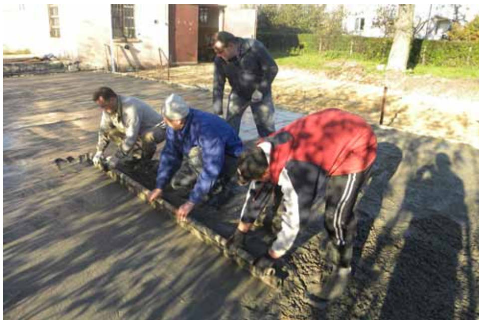
Szadłowice – kolektywna praca przy budowie placu
