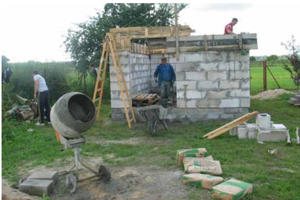
Wierzbiczany – fachowo wykonane roboty murarskie
